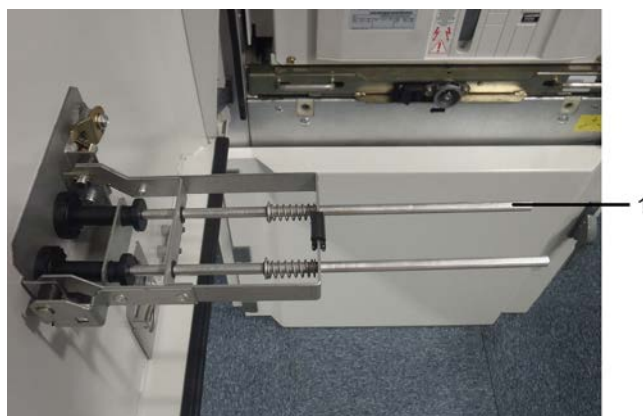
Рисунок 8. Вид выдвигной штанги штока после поворота при помощи поворотного рычага; выкатной элемент выключателя в контрольном положении, дверь открыта.
