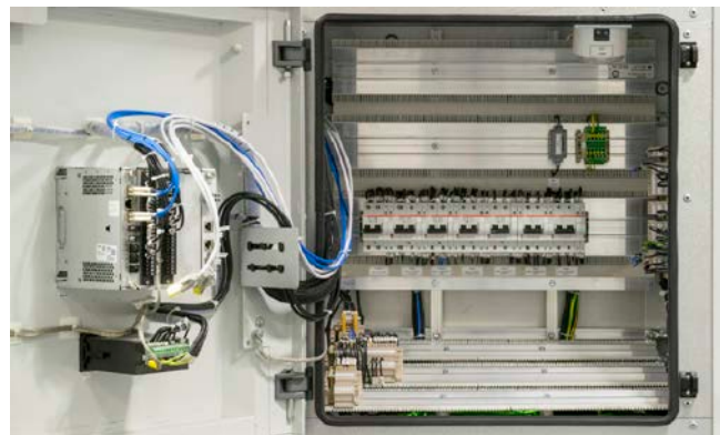
Рисунок 35. Монтажный профиль установлен на место
