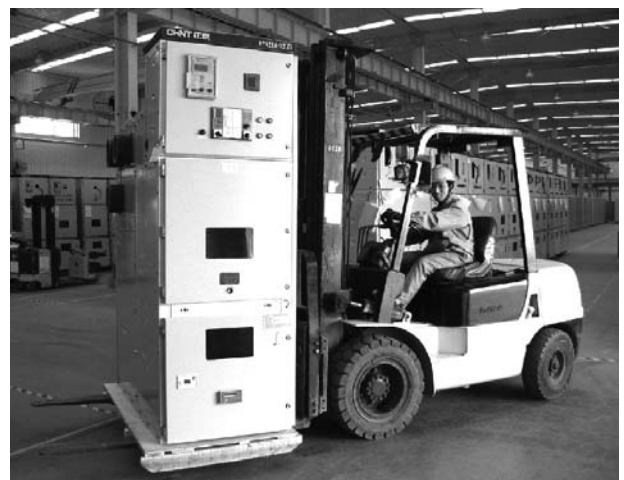
Рисунок 15. Погрузочно-разгрузочные работы при помощи вилочного погрузчика.
