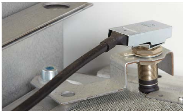
Рисунок 10. Концевой выключатель клапанной дуговой защиты. После снятия рым-болтов может возникнуть необходимость передвинуть концевые выключатели в рабочее положение.
