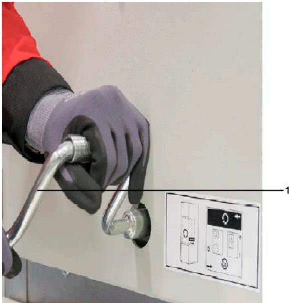
Рисунок 38. Перемещение выкатного элемента из тестового в рабочее положение и обратно. Повернуть рукоятку по часовой стрелке до упора – установка в рабочее положение; повернуть рукоятку против часовой стрелки – установка в положение Тест/Отключено.
