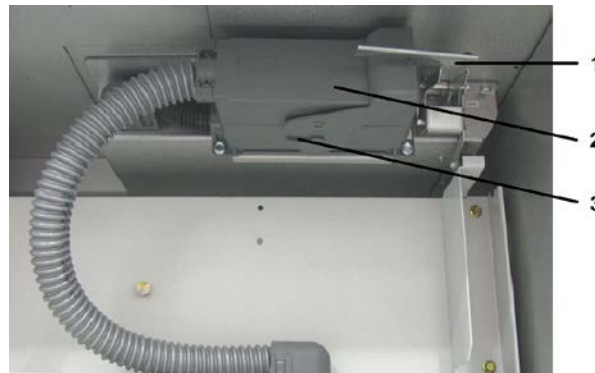
Рисунок 36. Разъем (вилка) цепи управления заблокирован для предотвращения отключения, когда выкатной элемент находится в рабочем положении.
