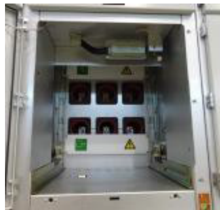
Рисунок 4. Аппаратный отсек с открытыми защитными шторками
