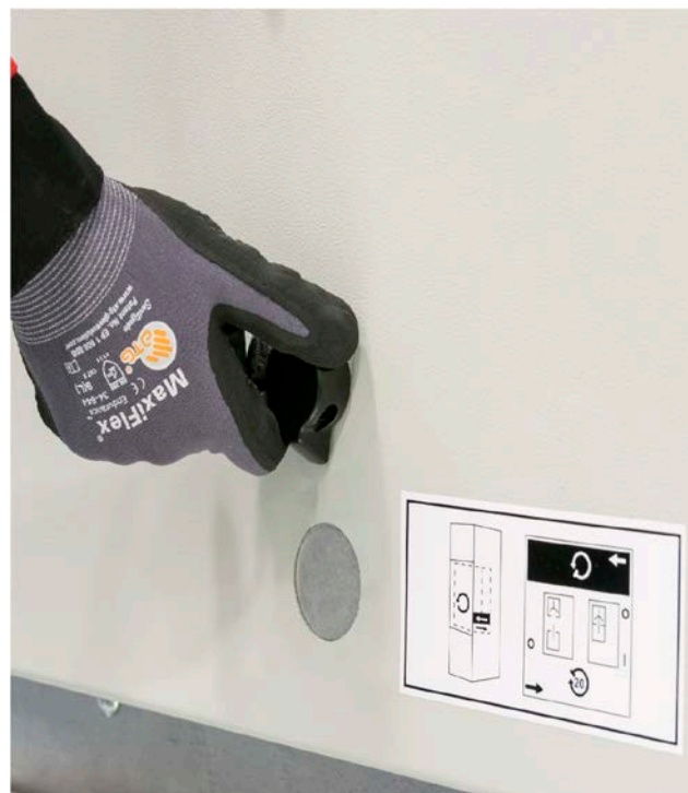
Рисунок 37. Перед вставкой рукоятки необходимо открыть отверстие – т.е. повернуть задвижку при помощи ключа.
